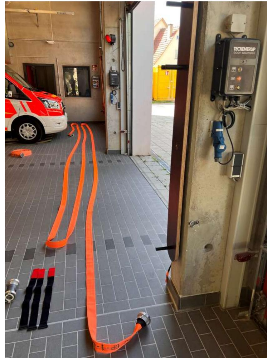
**Seitliches Auslegen des Schlauches**
