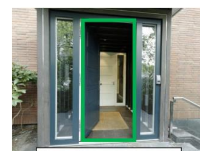
Zuluftöffnung: 2 qm Haustüre
